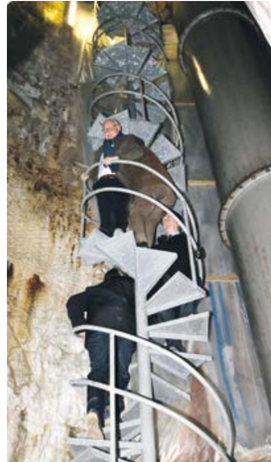
Mit der Wendeltreppe geht es 24 Meter in die Tiefe
