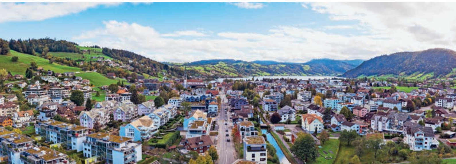
Unterägeri wie es heute aussieht. In Zukunft könnte hier ein modernes und lebenswertes Zentrum entstehen
