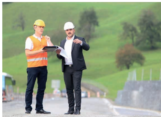
Baudirektor Florian Weber (rechts) und Projektleiter Niklaus Studer vergewissern sich über den Baufortschritt der Vorarbeiten für das Projekt Nidfuren–Schmittli.
